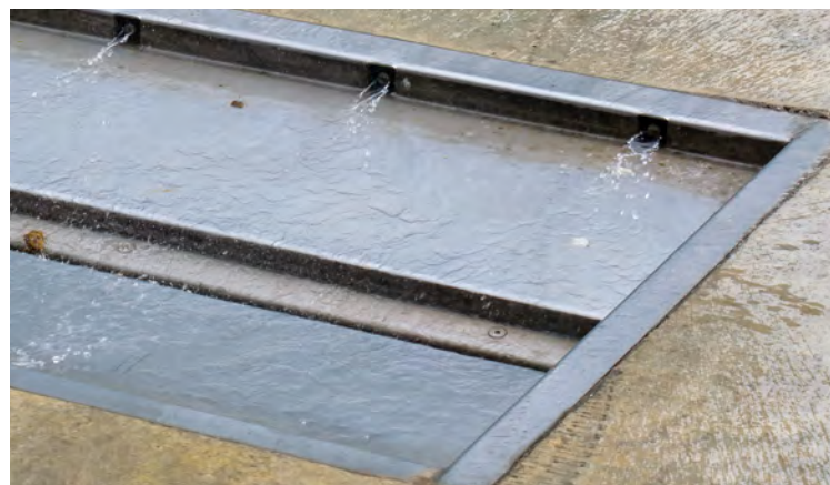
Il sistema autopulente dei pozzetti Camper Wc Wash.
